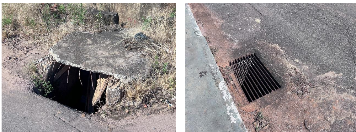
Figura 11 - Diferentes tipologias de bocas de lobo, bueiros e sarjetas do município de Capitólio (MG). Fonte: SERENCO.
