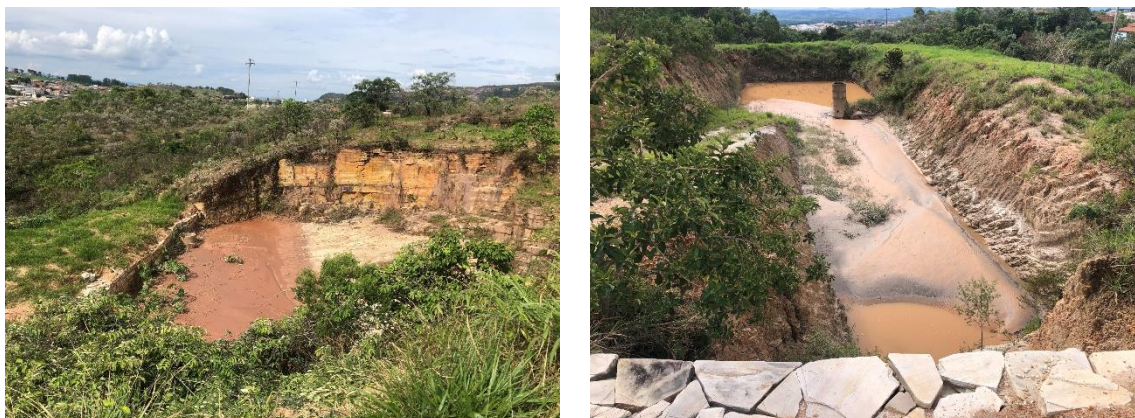
Figura 32 - Exemplo de Bacias de amortecimento de cheias (bacias de retenção) em loteamento. Fonte: SERENCO.
